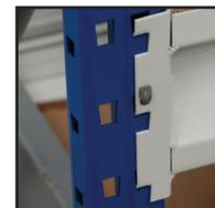
Befestigung de Längsträger und Verstärkungsbolzen
